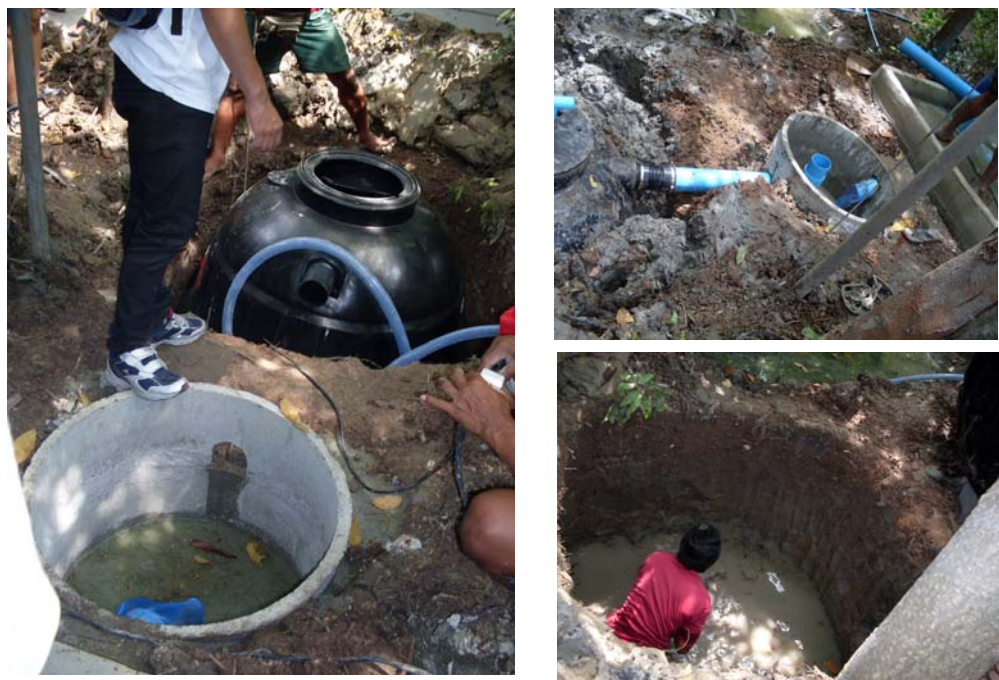
ภาพที่ 4.32 ภาพการติดตั้งถังดักไขมัน บริเวณรอบๆ ตลาดบางน้ำผึ้ง
