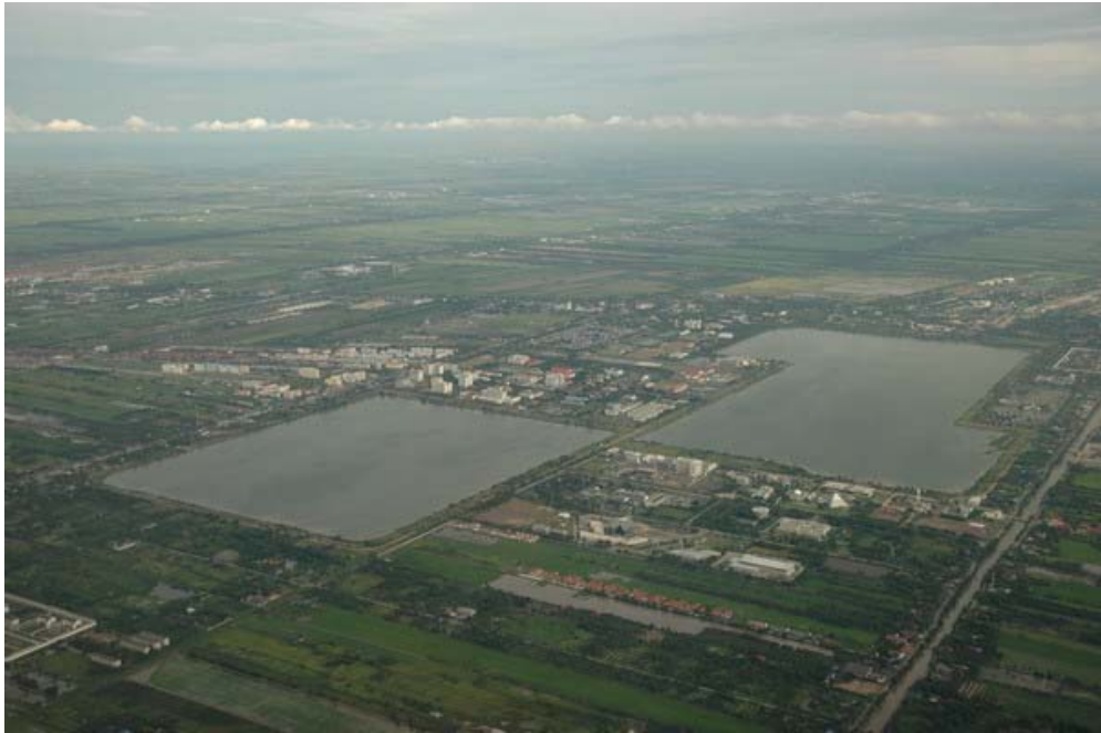
ภาพปิ้งพระรวม 9 การบำบัดด้วยระบบสระเติมอากาศ
