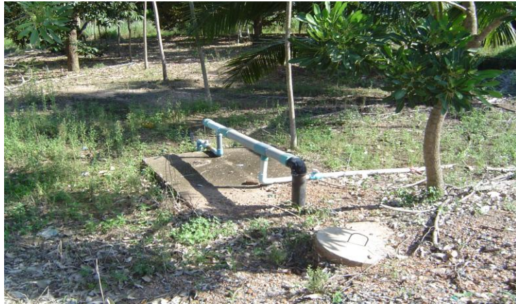
ภาพที่ 5.7 การเชื่อมต่อท่อจากท่อน้ำหลักเข้าพื้นที่ของเกษตรกร หมู่ที่ 11 ตำบลตะพง
