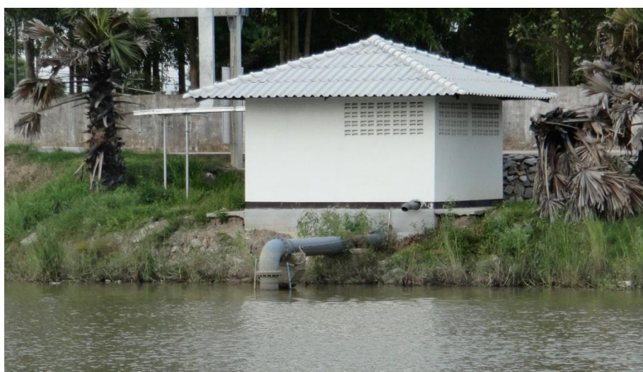
ภาพที่ 4.5 สถานีสูบน้ำด้วยไฟฟ้าหนองท่ากะสาว (โครงการสูบน้ำด้วยไฟฟ้าพร้อมระบบท่อส่งน้ำหนองท่ากะสาว – อ่างเก็บน้ำห้วยหินลาด)
