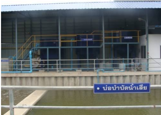
ภาพที่ 3.1 ระบบบำบัดของโรงงานอุตสาหกรรมรีไซเคิล
