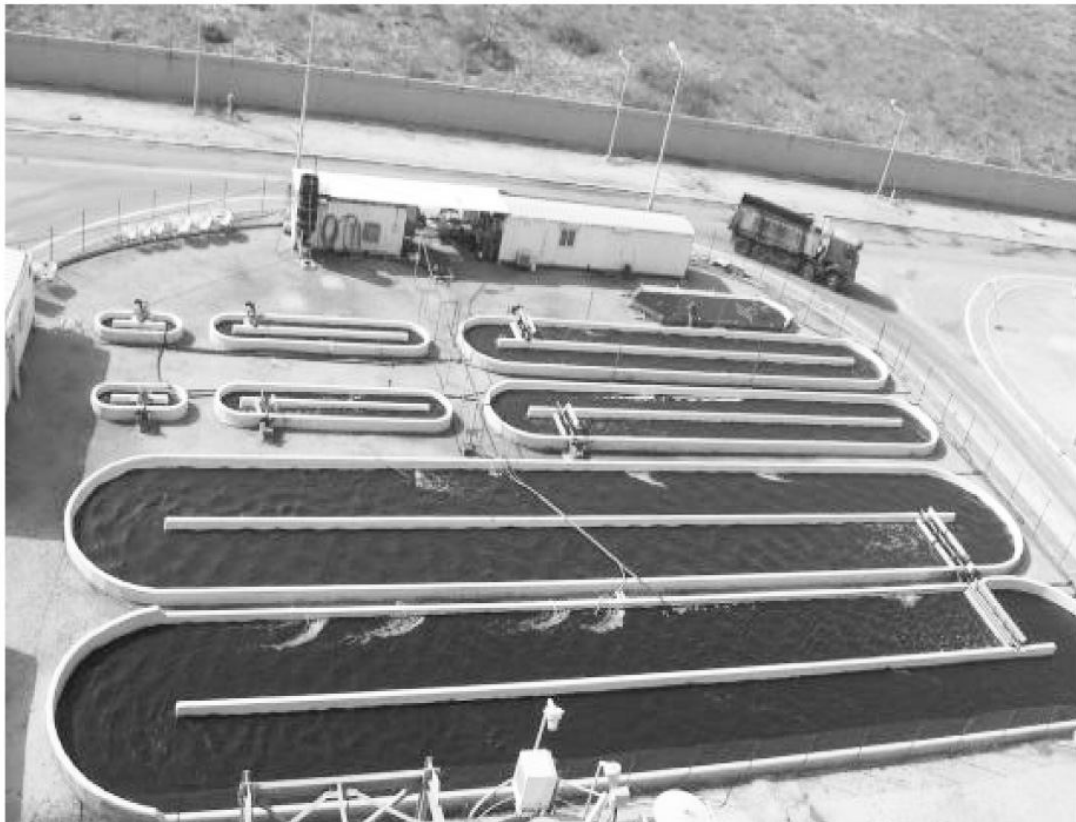
ภาพที่ 2.4 การเพาะเลี้ยงสาหร่ายระบบเปิดในบ่อกวนผสม ที่มา: แพรพิลาส ดุจจานุทัศน์, 2553
